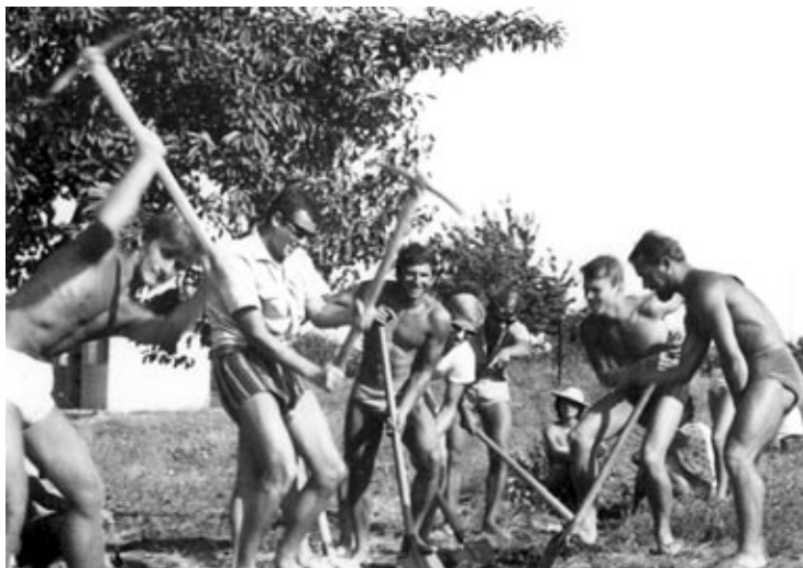
Pracujemy przy wykopie (Neseber, 1966)
