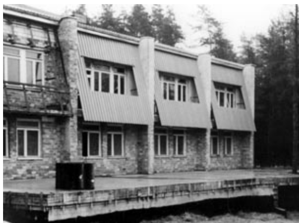
Stan surowy budynku hotelu i tarasu (1993)
