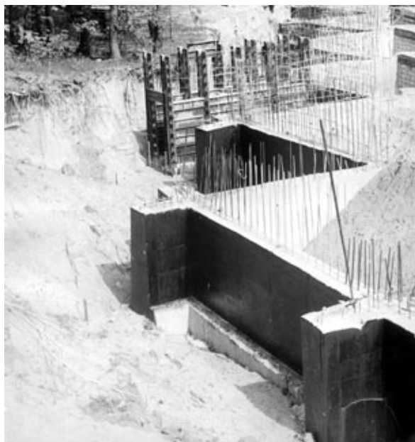
Fundamenty kompleksu hotelowego Ośrodka AWF Warszawa w Pięknej Górze
